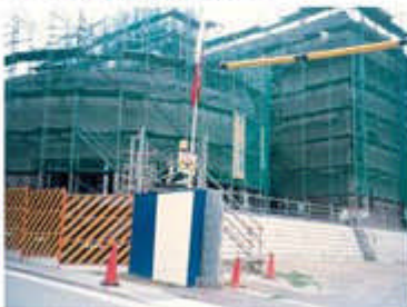
▲ 完成間近の工事現場
